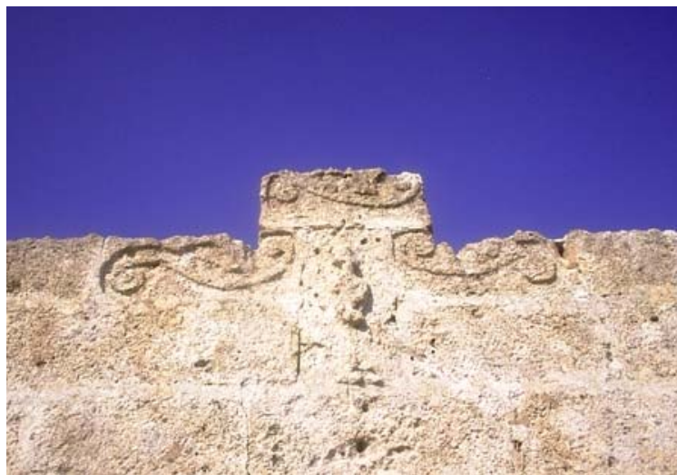
Il fregio decorativo sopra l'ingresso laterale del casone
